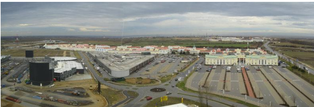
Die österreichische Gemeinde Parndorf, unmittelbar nördlich des Neusiedler Sees gelegen, hat sich in den letzten 13 Jahren zum Mekka der Outlet-Shopper entwickelt. Hier findet sich eine der größten Ansammlungen von Outlet Flächen in Europa. Das Center von McArthurGlen umfasst zwischenzeitlich fast 40.000 m 2 Verkaufsfläche... und es wird weiter gebaut: in Kürze kommen mit dem benachbarten Villagio (links im Bild mit dem schwarzen Turm) weitere 9.500 m 2 VK dazu.
