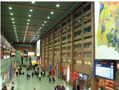
Der Innsbrucker Hauptbahnhof wurde im Rahmen der „Bahnhofs-Offensive“ der ÖBB Österreichischen Bundesbahnen abgerissen und als modernes Mobilitäts- und Geschäftszentrum neu errichtet.
