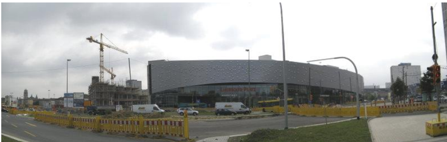
Ansicht des Shopping Centers „Limbecker Platz“ vom Berliner Platz (Kreuzungsbereich Ostfeldstraße / Altendorfer Straße); der 2. Bauabschnitt ist hier im Bild (links) noch in der Bauphase. Das Center befindet sich im Schnittpunkt bedeutender, stark frequentierter Hauptverkehrsachsen der Stadt und dockt gleichzeitig an die als Fußgängerzone ausgewiesene Haupteinkaufslage der Innenstadt an. Außerdem verfügt der Standort über eine unmittelbare Anbindung an das Stadtbahnnetz innerhalb des Centers.
