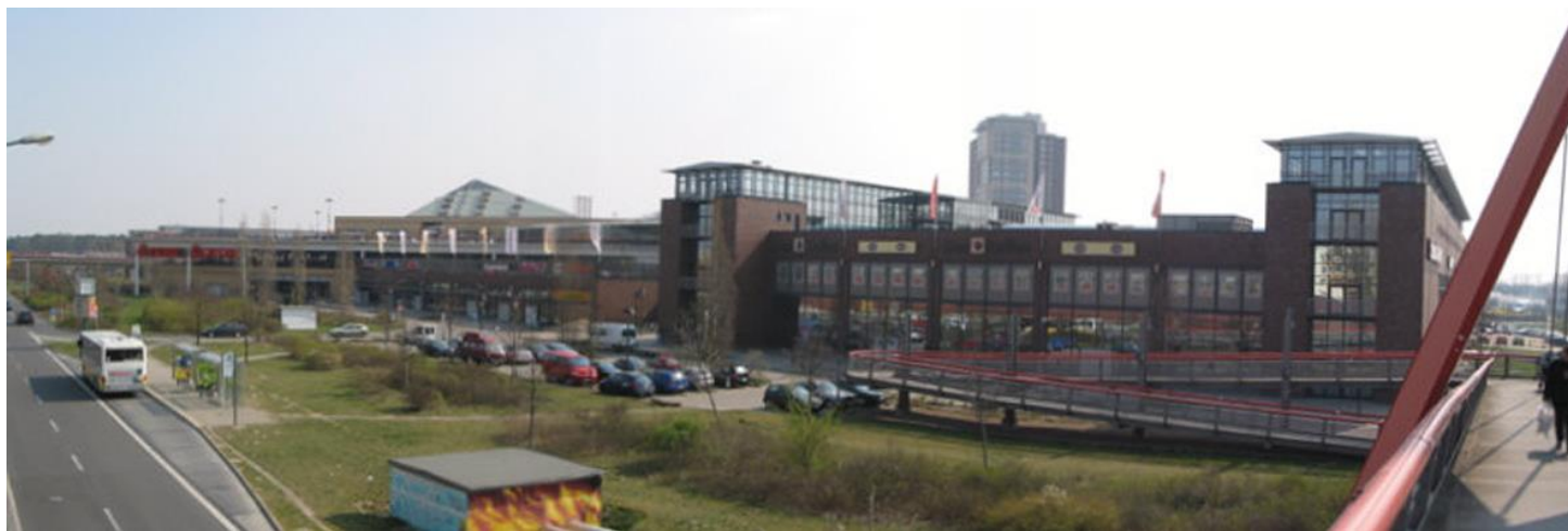
Beim EKZ Stern Center an der Nuthestrasse handelt es sich um einen autokundenorientierten Standort am östlichen Stadtrand in der Nähe der BAB A 115 Anschlussstelle Potsdam-Babelsberg
