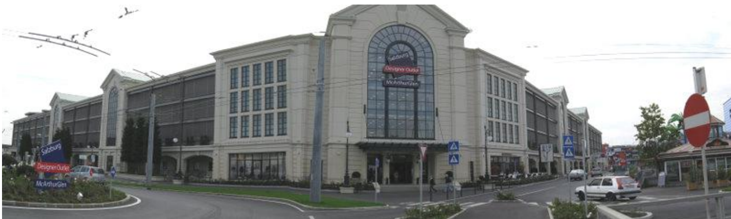
Am Standort des neu eröffneten „Salzburg Designer Outlet Center“ befand sich vorher ein Shopping Center, das in die Krise gekommen war. Die alten Gebäude wurden weitestgehend abgetragen und ein Outlet Center mit Rundlauf auf zwei Verkaufsebenen realisiert.
