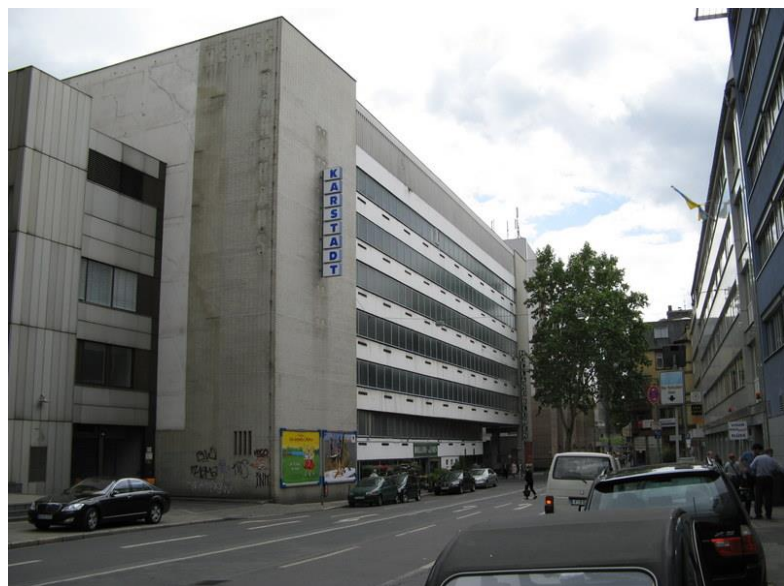
Guter Standort in unmittelbarer Nähe zur Haupteinkaufslage, aber bereits deutlich in die Jahre gekommen und mit einem erheblichen Sanierungsbedarf: das Parkhaus des Karstadt Kauf- und Warenhauses an der Zeil in Frankfurt am Main
