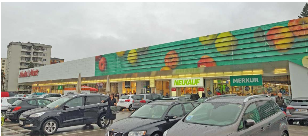
Das Einkaufszentrum „neukauf Spittal“ ist ein sog. „hybrides Shoppingcenter“, d.h. eine Mischform aus Mallcenter und Fachmarktzentrum. Ankerbetriebe sind jeweils ein großdimensionierter Merkur-Verbrauchermarkt sowie ein Media-Markt-Elektrofachmarkt.
