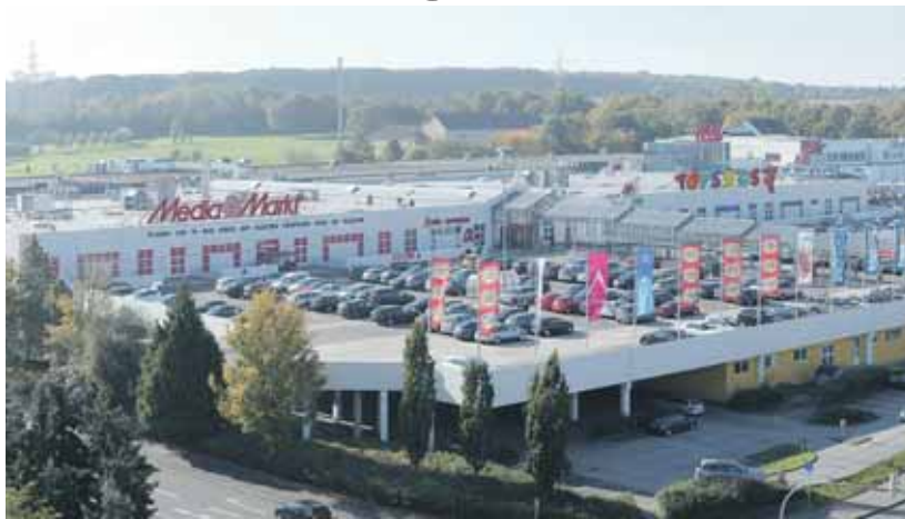
Das Südring-Center in Paderborn landet mit der Note 1,71 auf Platz 5.
